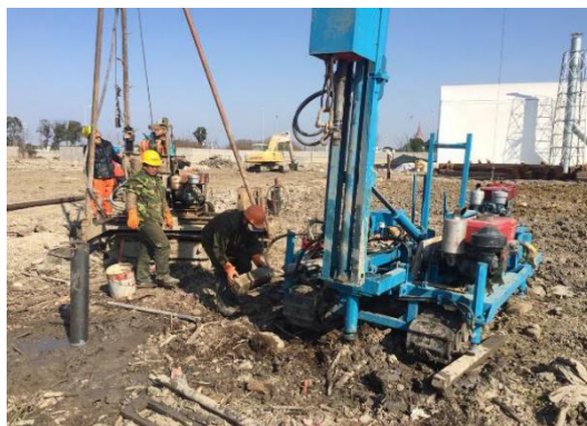
图 7-25 钻孔下管
