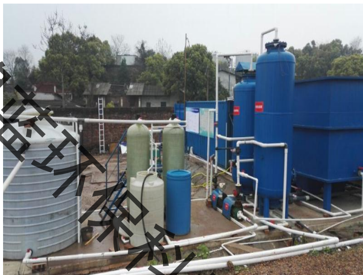
图 11-23 CMEC 一体化废水处理系统设备图
