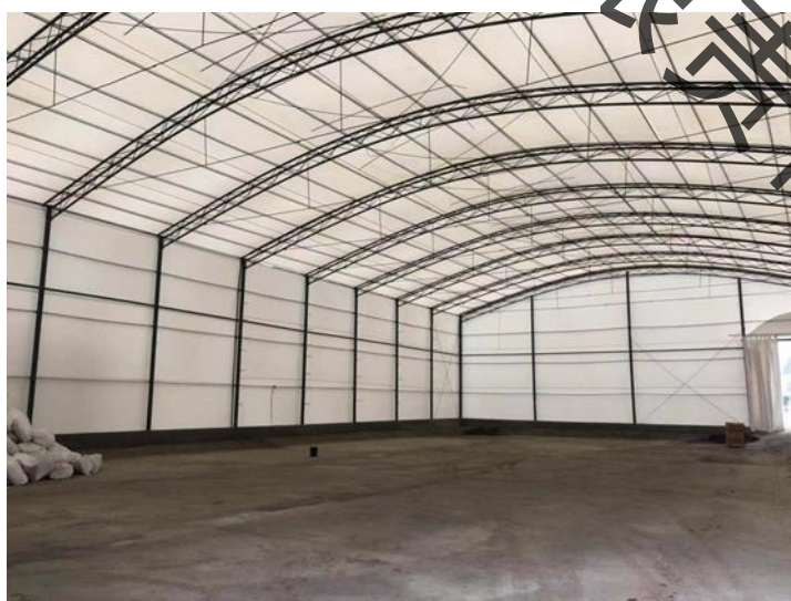
图 11-8 密闭大棚内部结构图
