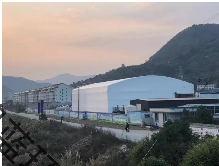
图 7-5 密闭钢结构膜大棚实景图
