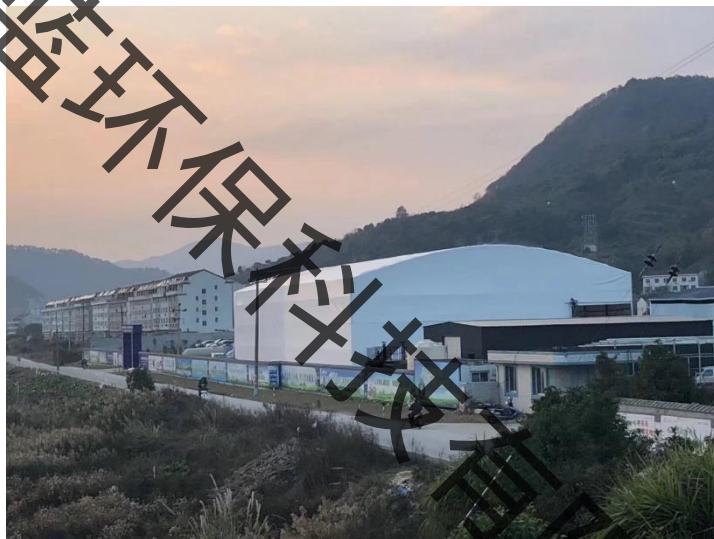
图 11-7 密闭钢结构膜大棚实景图
