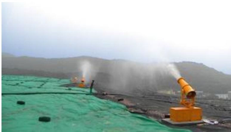
图 3-6 雾炮喷射降尘
