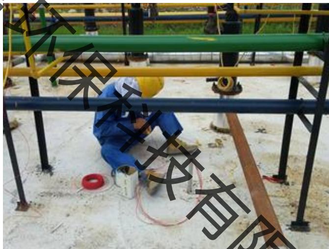
图 7-26 温度测线的制作
