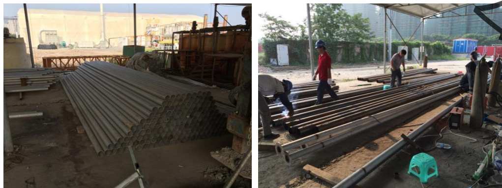
图 7-23 管道堆放和现场焊接
