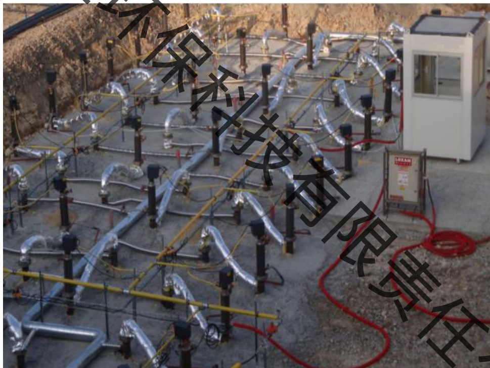
图 11-10 原位热脱附设备现场工作图 1
