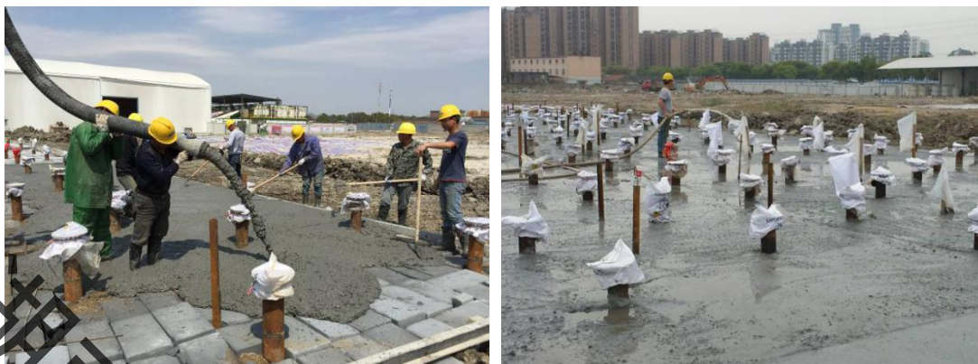
图 7-33 浇筑混凝土及氧化
