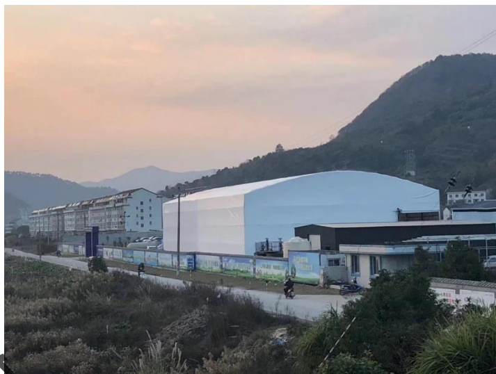
图 4-4 密闭钢结构膜大棚实景图
