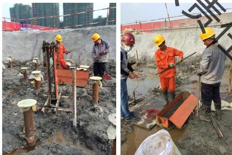
图 7-27 温度测点引孔
