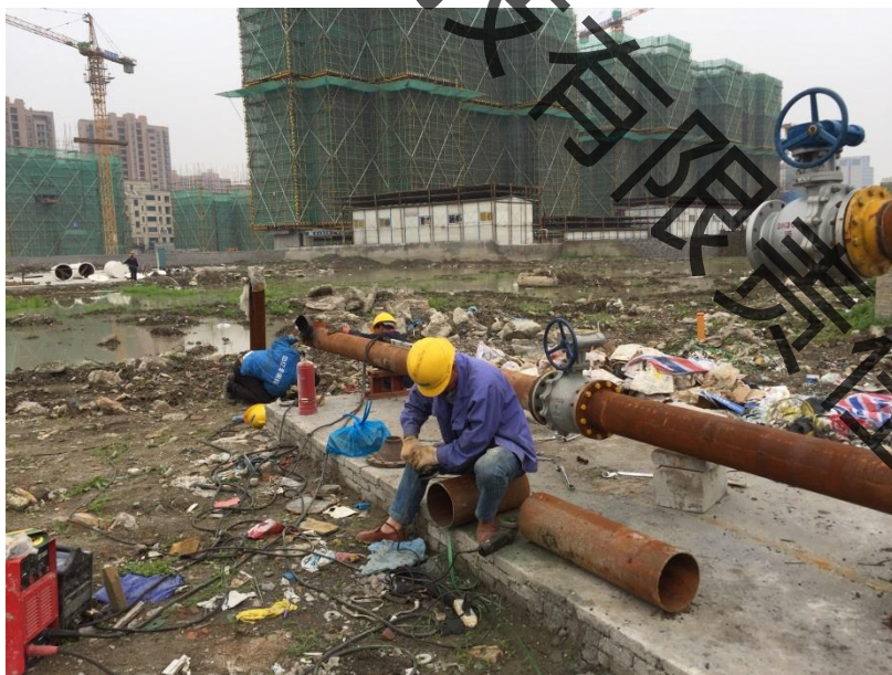
图 7-20 管口打磨
